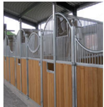
Schiebetüren mit Gitter im unteren Teil zur besseren Belüftung
